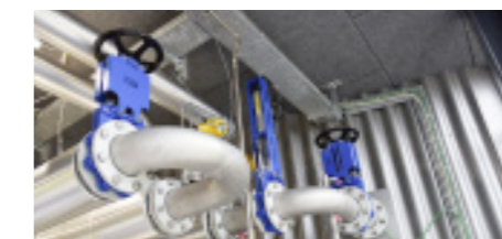
I rådnetanken recirkuleres slammet gennem en varmeveksler.
