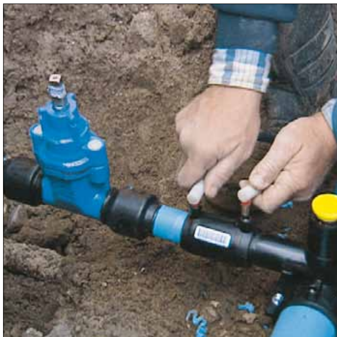
Installation af en stikledningsventil med PE-ender.
