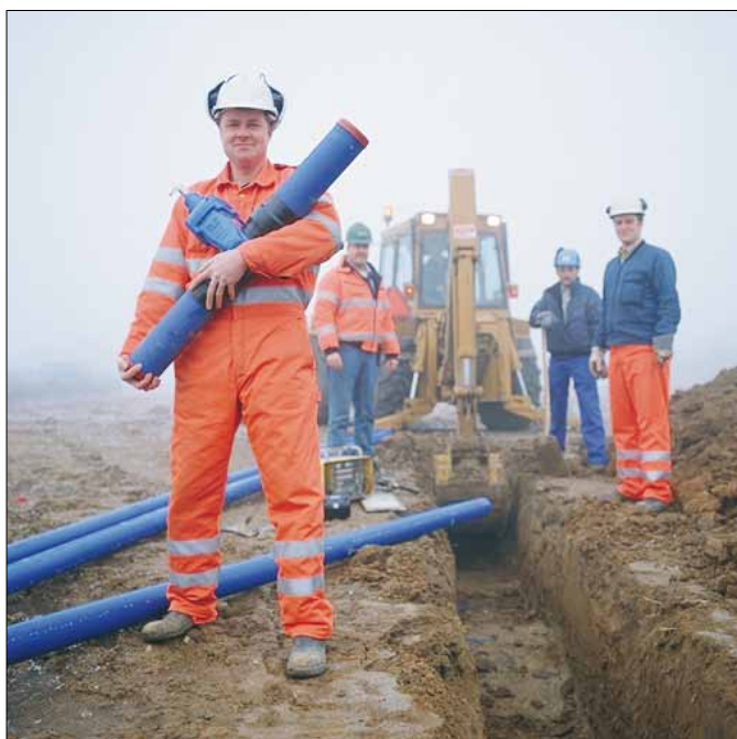
Installation af et PE-rørnet.
