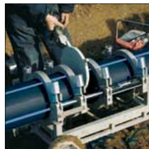
Stuksvejsning er en teknik, der har været anvendt i mange år til samling af PE-rør.
