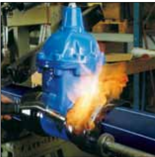
Klemringen korrosionsbeskyttes med en krympeslange.
