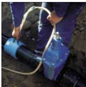
Elektromuffesvejsning er en hurtig og effektiv teknik.
